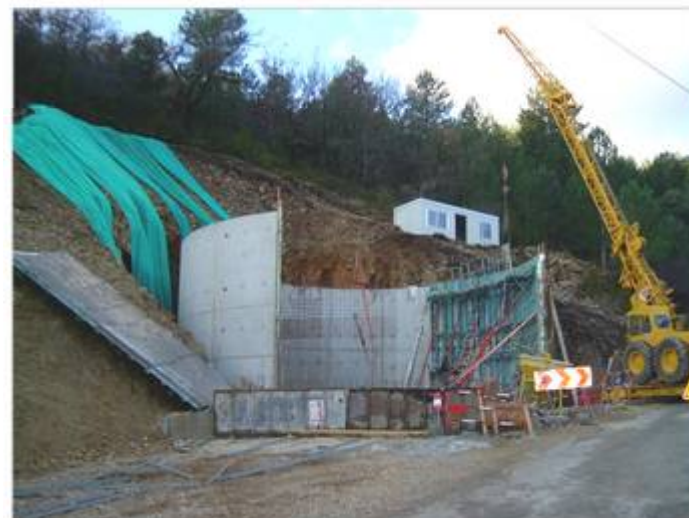
Pendant les Travaux
